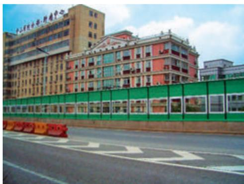
图 1.3.4 高架道路旁的隔音板
