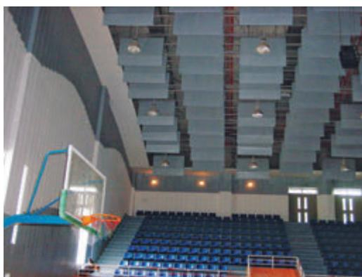
图 1.3.3 体育馆顶部的吸音材料
