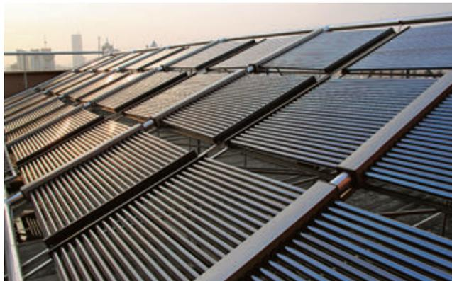
图6.2.2 大面积太阳能热水系统
