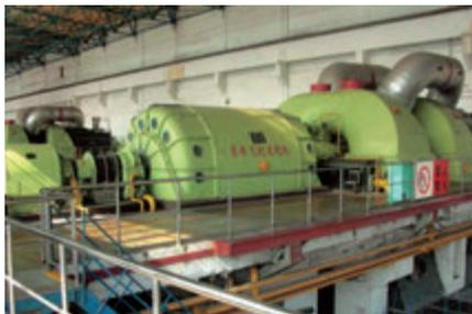
图6.1.2 汽轮发电机
