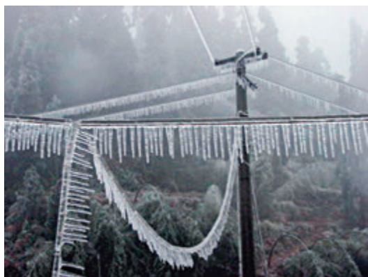
图 1.2.8 冻雨下落到输电线上形成冰柱
