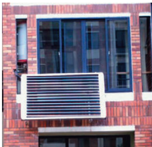
图3.1.9 太阳能热水器
